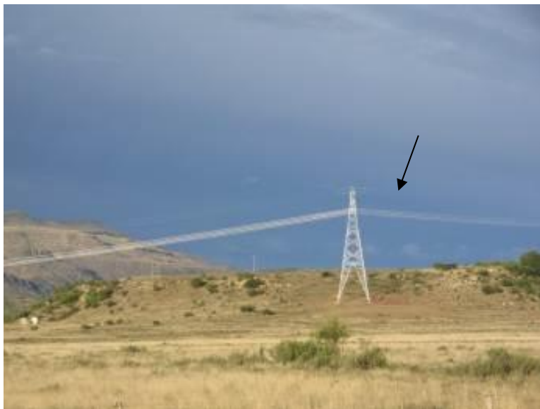
Figura 16. Una línea de 400 kV con todos los cables conductores en el mismo plano horizontal. Esta imagen también muestra el fino cable de tierra casi invisible (flecha negra) en la parte superior (foto: EWT-WEP).
