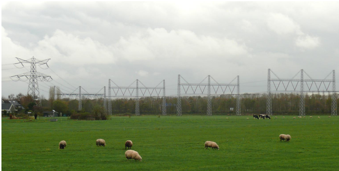
Figura 17. Una línea de 380 kV con cables conductores bajos colgando de los portales en un plano horizontal para minimizar el riesgo de colisión del Cormorán Grande ( Phalacrocorax carbo ), la Espátula Común ( Platalea leucorodia ) y la Garza Imperial ( Ardea purpurea ), que salvan este tramo de línea a diario a la vez mientras conmutan entre la colonia de reproducción y las áreas de recolección, Muiden, Países Bajos (Foto: Bureau Waardenburg).
