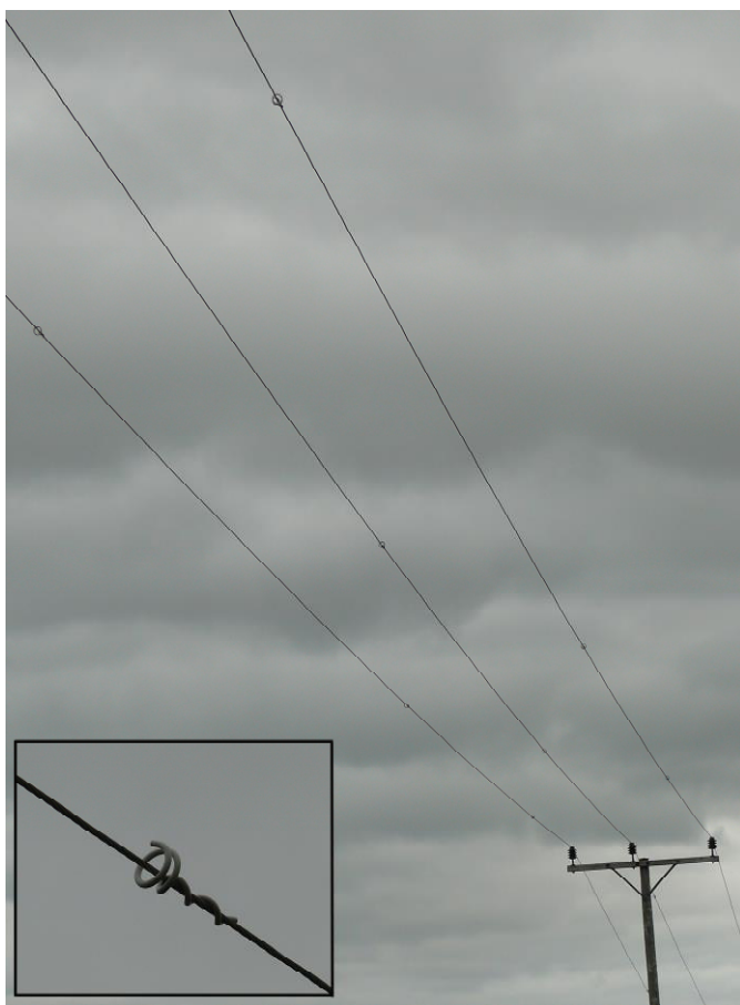
Figura 19. Línea de distribución de medio voltaje con pequeñas espirales (las llamadas ‘colas de cerdo’) situadas a intervalos regulares en los conductores como desviadores de aves en vuelo (foto: Bureau Waardenburg).
