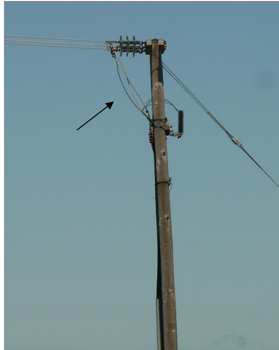
Figura 3. Izquierda: Subestación de distribución con algunas partes energizadas poco espaciadas potencialmente peligrosas para las aves. La modificación podría incluir el aislamiento de cables suspendidos verticalmente y una separación espacial de las partes energizadas. Derecha: poste terminal de la línea de distribución; los cables de puente (flecha) están montados debajo de los conductores y los aislantes tienen más de 60 cm de largo, proporcionando una percha segura para las aves en la punta del poste (Fotos: Bureau Waardenburg).
