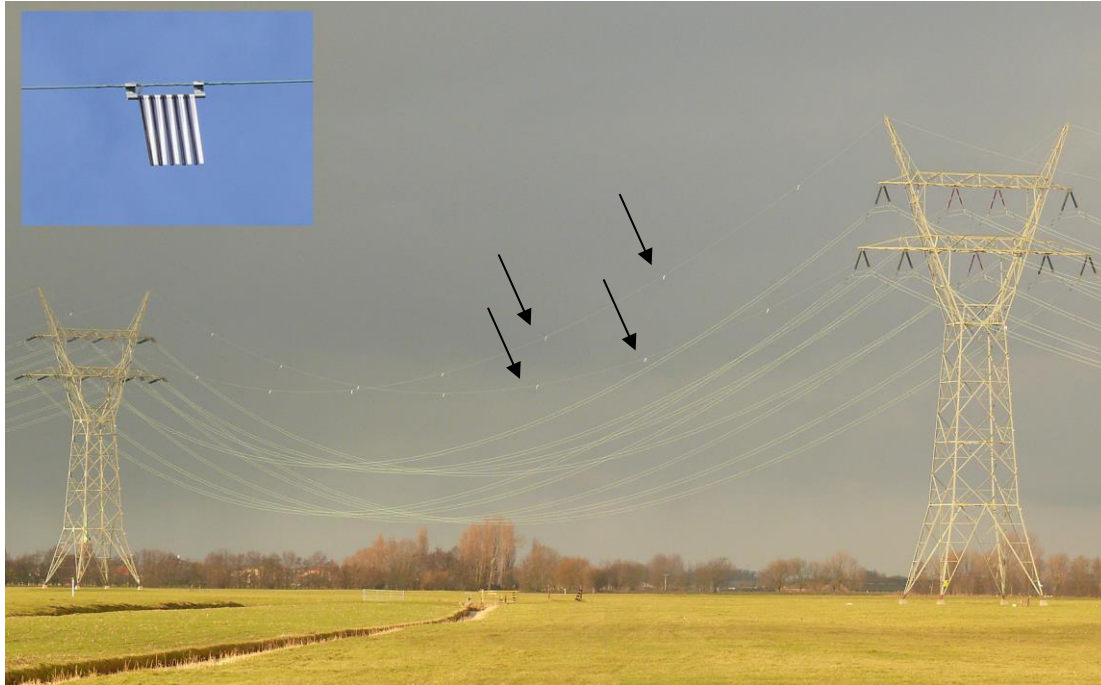
Figura 20. Tendido eléctrico de alta tensión (150 kV) en los Países Bajos con aletas (véase flechas) situadas a intervalos regulares en ambos cables de tierra como desviadores de aves en vuelo, véase también Recuadro 1 (Foto: Bureau Waardenburg).
