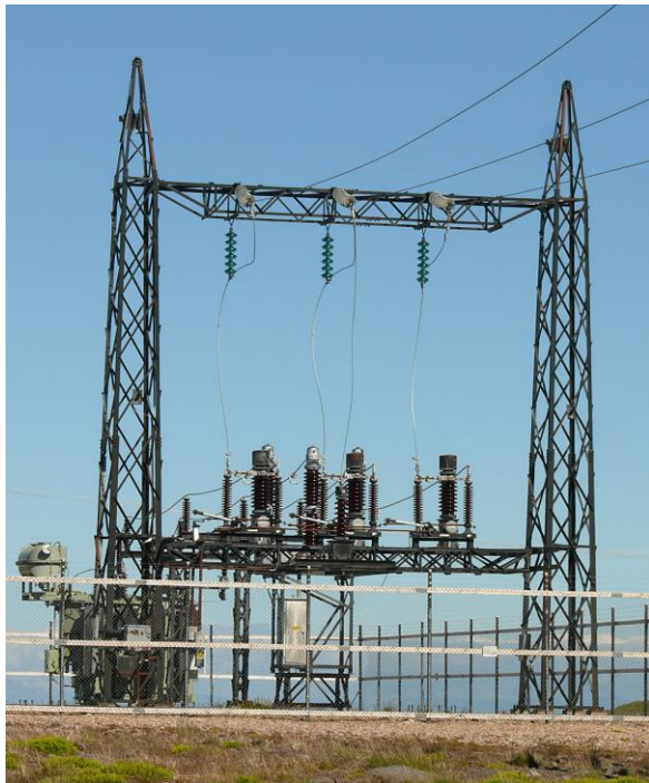
Figura 3. Izquierda: Subestación de distribución con algunas partes energizadas poco espaciadas potencialmente peligrosas para las aves. La modificación podría incluir el aislamiento de cables suspendidos verticalmente y una separación espacial de las partes energizadas. Derecha: poste terminal de la línea de distribución; los cables de puente (flecha) están montados debajo de los conductores y los aislantes tienen más de 60 cm de largo, proporcionando una percha segura para las aves en la punta del poste (Fotos: Bureau Waardenburg).
