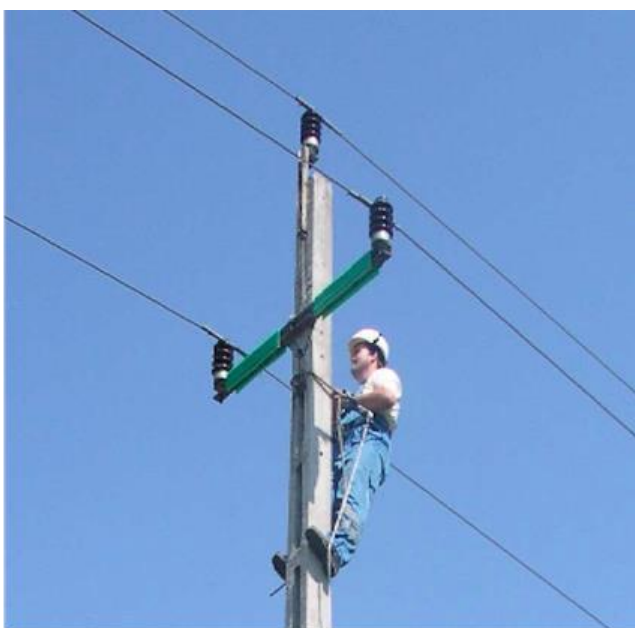
Figura 7. Aislamiento de cruceta llevado a cabo en Hungría (Fuente: Horvath et al., 2011).
